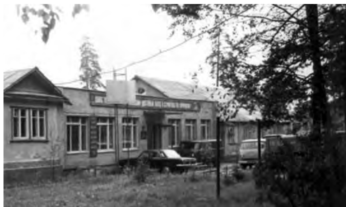
Здание управления ВНИИ ПМ в Протвино с 01.11.1974 г. по 01.01.1979. Фото 1976 г.
