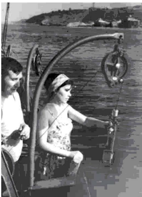
Рис. 4. Отбор проб воды на микробиологический анализ на НИС «Наука». Фото слева – И.В. Михеева, справа – А.В. Иватин
